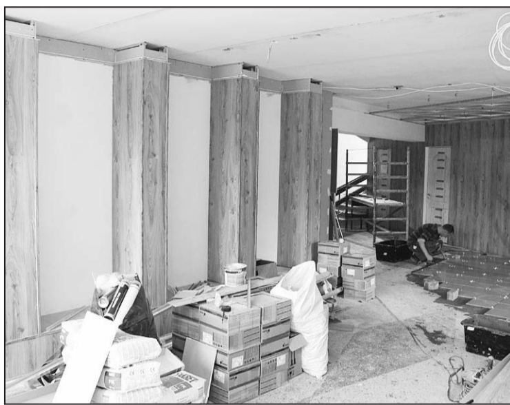
Rit remontdarbi administratīvās ēkas 1. stāva foajē, kur būs Valsts un pašvaldību vienotais klientu apkalpošanas centrs.
