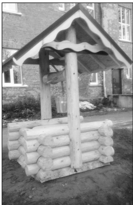
Silajāniešu realizētais projekts – novecojušais akas augšējais grods aizvietots ar koka guļbūvi.
