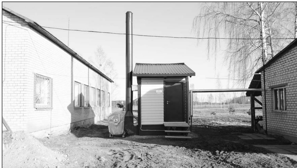
Jaunā konteineru tipa katlu māja izvietota starp bijušo katlu māju un Sīlukalna kultūras namu.
